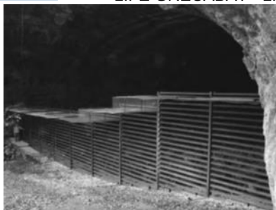
Εικόνα 4. Διαφορετικοί τύποι πυλών σε εισόδους (α) μισή πύλη που εφαρμόστηκε στο σπήλαιο Great Spirit στο Pulaski County στο Μιζούρι των ΗΠΑ (Fant et al. , 2009; Elliott, 2006b) και (β) πύλη με παράθυρο στο σπήλαιο Bacon, Βιρτζίνια ΗΠΑ (Fant et al. , 2009).
