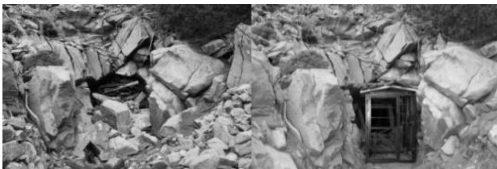
Εικόνα 8. Αποκατάσταση εισόδου στοάς του ορυχείου Χατζηπαύλου στην Κύπρο πριν και μετά τις εργασίες αποκατάστασης στα πλαίσια του Προγράμματος LIFE09 NAT/CY/000247 15
