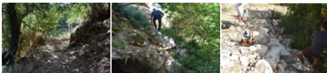
Εικόνα 29. (α) Σημείο Δ: όψη προς ιδιοκτησία Αγγελάκη – θέση περίφραξης(β)Σημείο Γ: όψη προς αγροτική οδό από την είσοδο του σπηλαίου(γ)Σημείο Γ: όψη προς αγροτική οδό και επαρχιακή οδό – θέση περίφραξης.
