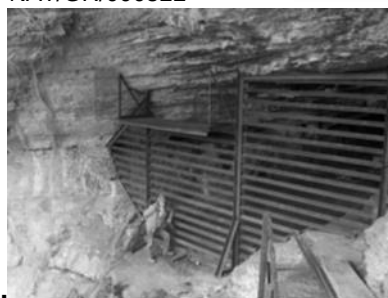
Εικόνα 4. Διαφορετικοί τύποι πυλών σε εισόδους (α) μισή πύλη που εφαρμόστηκε στο σπήλαιο Great Spirit στο Pulaski County στο Μιζούρι των ΗΠΑ (Fant et al. , 2009; Elliott, 2006b) και (β) πύλη με παράθυρο στο σπήλαιο Bacon, Βιρτζίνια ΗΠΑ (Fant et al. , 2009).
