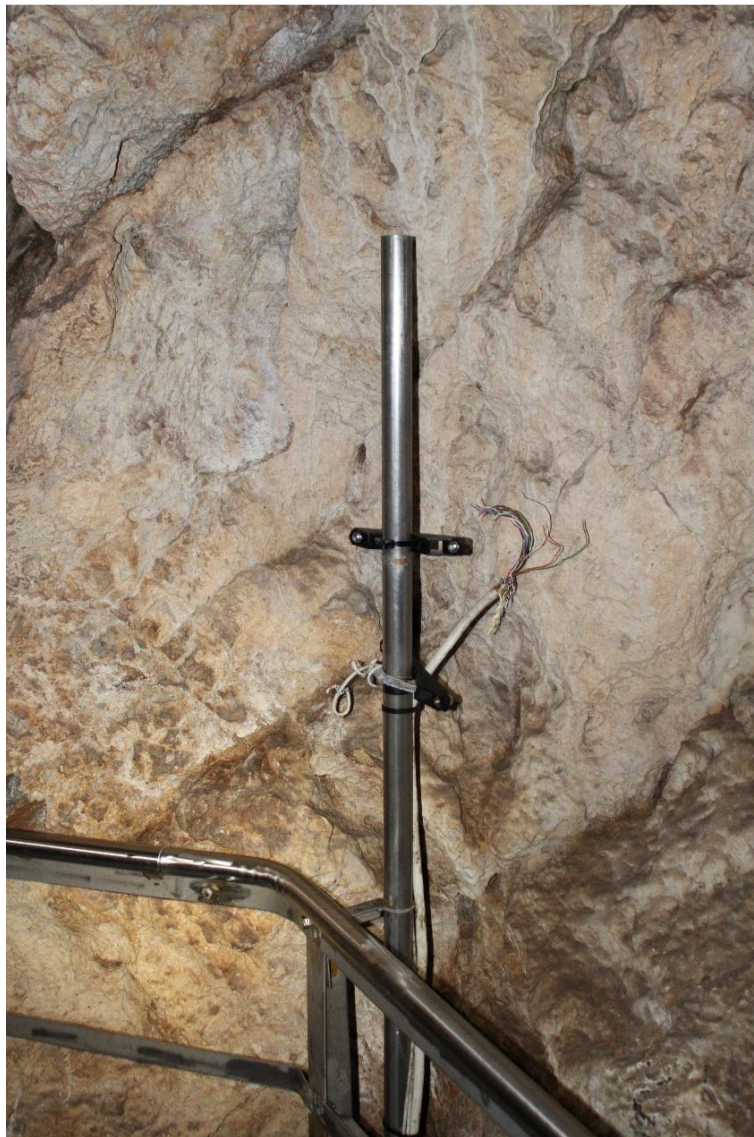
Εικόνα 9. Ανοξείδωτος σωλήνας που θα τοποθετηθούν τα νέα συστήματα
