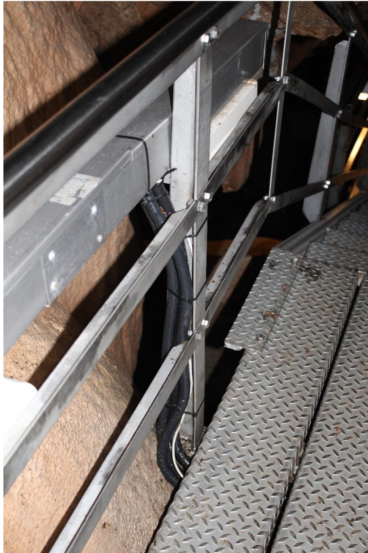
Εικόνα 8. Το ανοξείδωτο κανάλι όλων των καλωδίων
