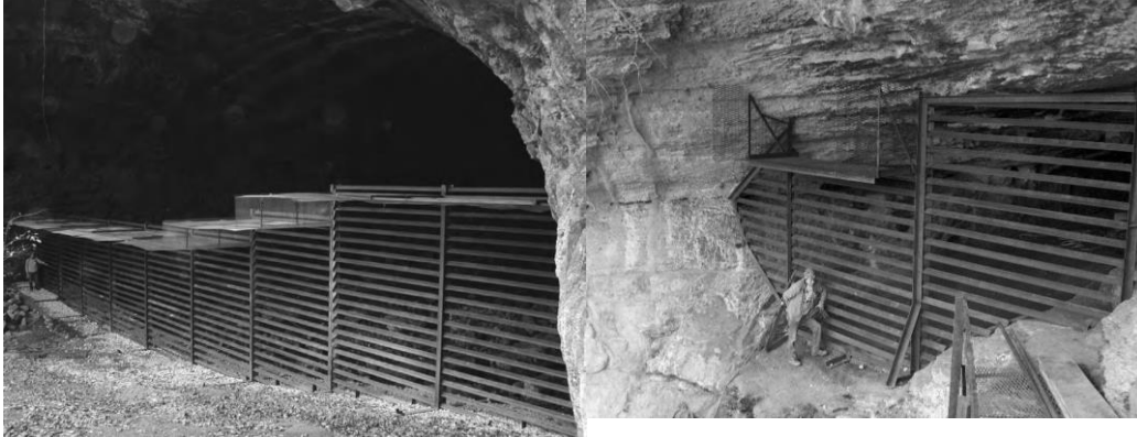
Εικόνα 3. Διαφορετικοί τύποι πυλών σε εισόδους (α) μισή πύλη που εφαρμόστηκε στους πήλαιο Great Spirit στο Pulaski County στο Μισούρι ΗΠΑ (Fant etal. , 2009; Elliott, 2006b) και (β) βασική πύλη με παράθυρο στο σπήλαιο Bacon, Βιρτζίνια ΗΠΑ (Fant etal. , 2009).
