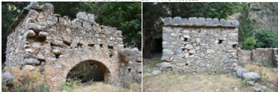
Εικόνα 8. Νοτιοδυτική και βορειοδυτική όψη του προτεινόμενου προς αποκατάσταση κτιρίου
