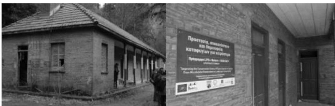
Εικόνα 6. Ανατολικό κτήριο στην περιοχή Σταυρός Ψώκας – Καρκαβάς στη Κύπρο, πριν και μετά τις εργασίες αποκατάστασης στα πλαίσια του Προγράμματος LIFE ICOSTACY (LIFE09NAT/CY/000247
