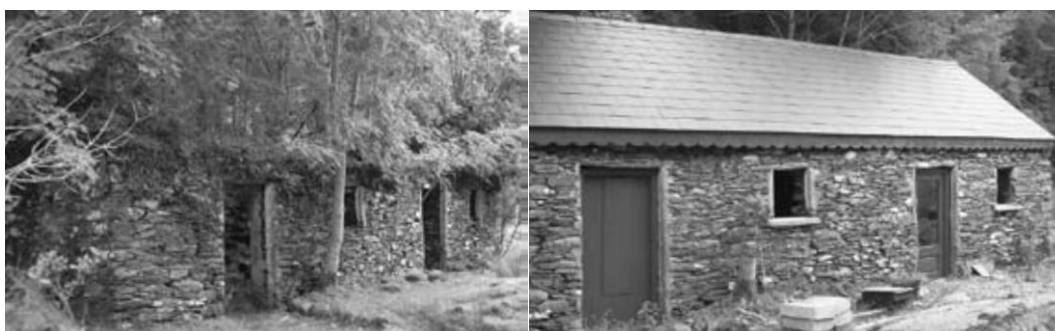
Εικόνα 5. Το κτήριο στο Glaninchiquin πριν και μετά το τέλος των εργασιών αποκατάστασης (Marnell & Presetnik, 2010). Οι εργασίες αποκατάστασης περιλάμβαναν δημιουργία παταριού με δύο πόρτες και ένα σημείο πρόσβασης.
