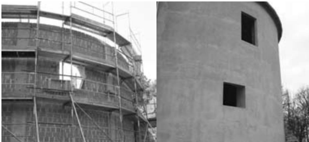
Εικόνα 2. Ανοικοδόμηση του πύργου Gradna Goričkem που έδειξε να χρησιμοποιείται από σημαντικό αριθμό χειροπτέρων στη Σλοβενία όπου σπανίζουν οι φυσικοί βιότοποι για χειρόπτερα, κατά την κατασκευή και μετά (Marnell & Presetnik 2010).
