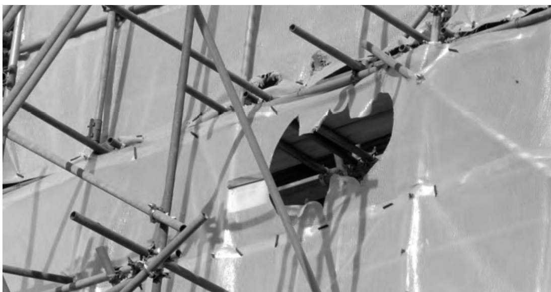
Εικόνα 3. Εργασίες αποκατάστασης στέγης στο Killerton House στο Devon, όπου χρειάστηκε να τοποθετηθούν σκαλωσιές. Κατά τη διάρκεια των εργασιών εφαρμόστηκε προστατευτικό κάλυμμα με ανοίγματα για τη διέλευση των χειροπτέρων. Μετρήσεις μετά το τέλος των εργασιών έδειξαν ότι τα χειρόπτερα επέστρεψαν στο κτήριο σε πληθυσμούς παρόμοιους με αυτούς πριν την εκτέλεση των εργασιών (Howard et al. , 2009).
