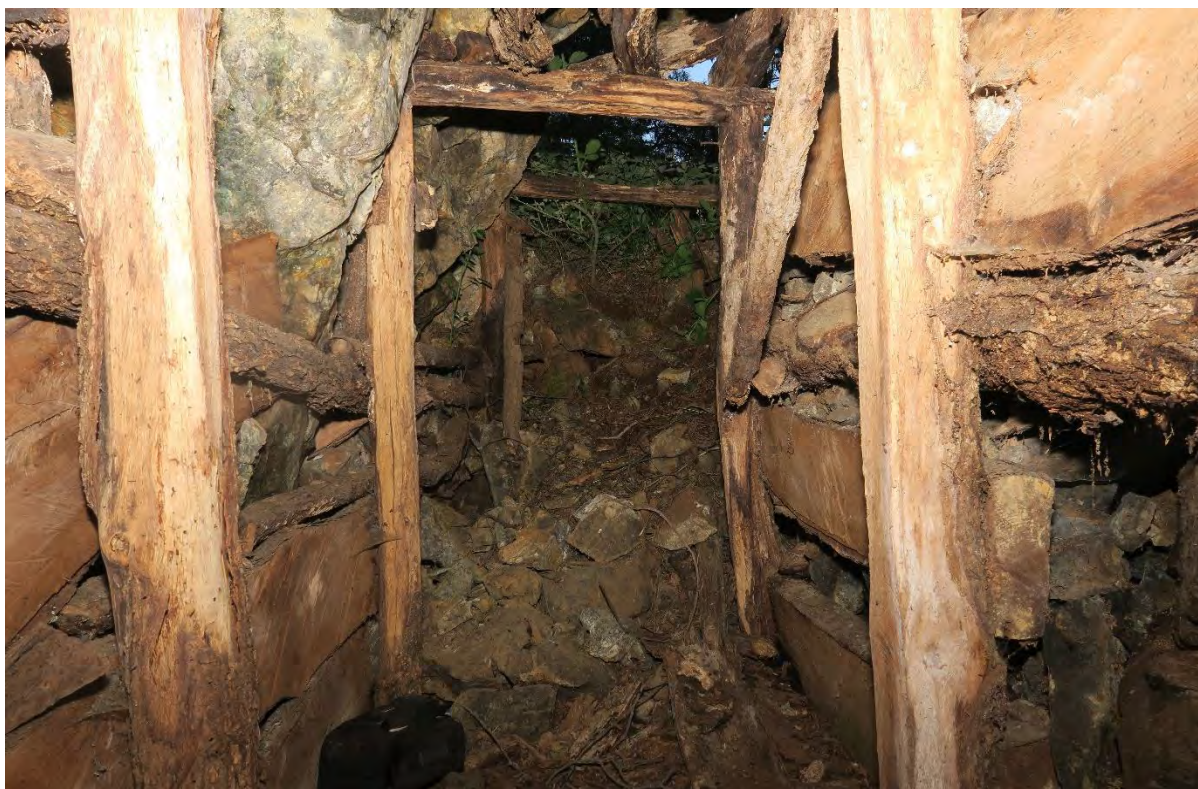
Φωτογραφία 38. Η είσοδος του ορυχείου του Τσούτουρου από μέσα. Διακρίνονται πεσμένες πέτρες, σάπιες δοκοί και η νέα και μία από τις δύο νέες εισόδους (πάνω).
